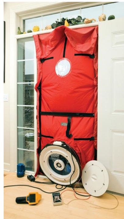
Blower Door Test
