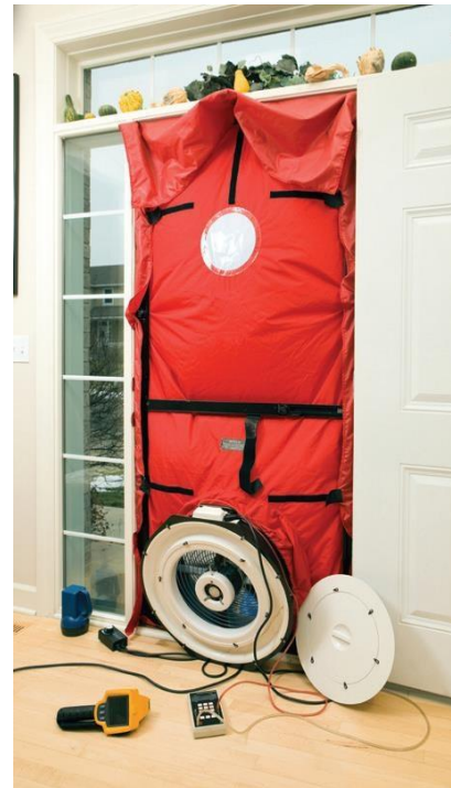
Blower Door Test
